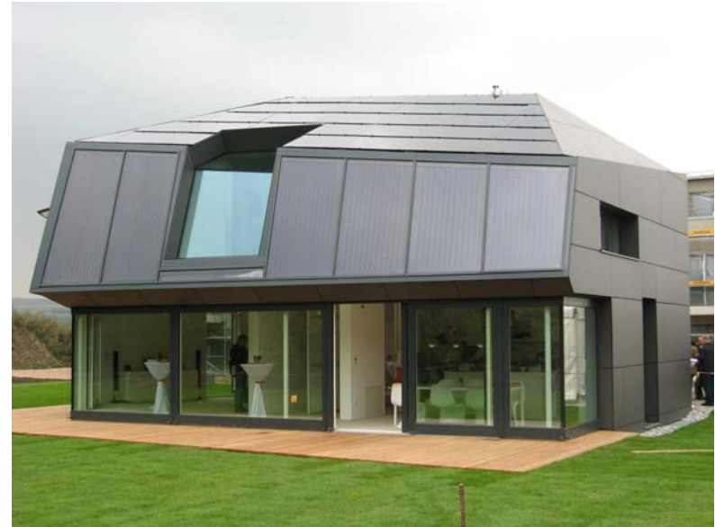
Haus der Zukunft, Regensburg Projekt-Team: Sonnenkraft, fabi architekten, Hochschule Regensburg, Fraunhofer ISE
