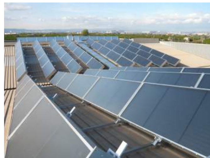
Orangentrocknung, Garcia Ballester 450 m 2 , 2009
