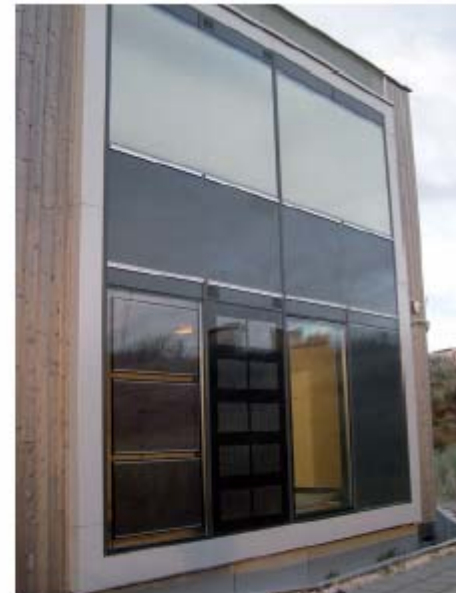
Abbildung 27: Transparenter solarthermischer Kollektor (links), (Quelle: ISE, Deutschland)
