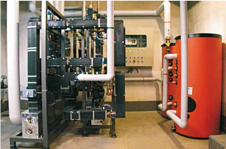
Vorgefertigte Hydraulikzentrale für Solaranlagen in Mehrfamilienhäusern
