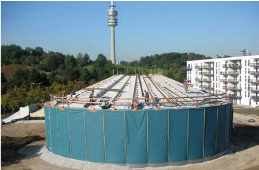
Bau des saisonalen Wärmespeichers in München
