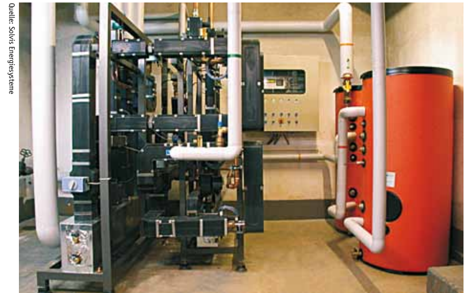
Vorgefertigte Hydraulikzentrale für Solaranlagen in Mehrfamilienhäusern
