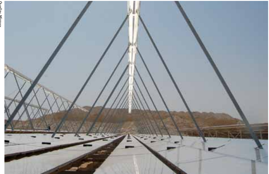
Fresnel-Kollektor zur Prozesswärmeerzeugung von 180 °C
